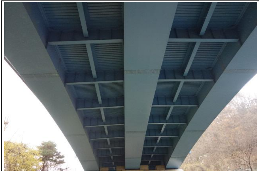
STB 거더 구간 하면 전경
