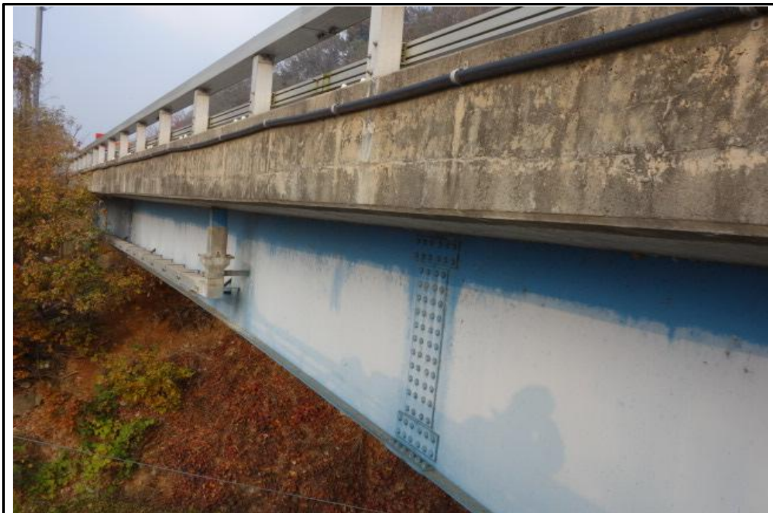
STB 거더 구간 측면 전경
