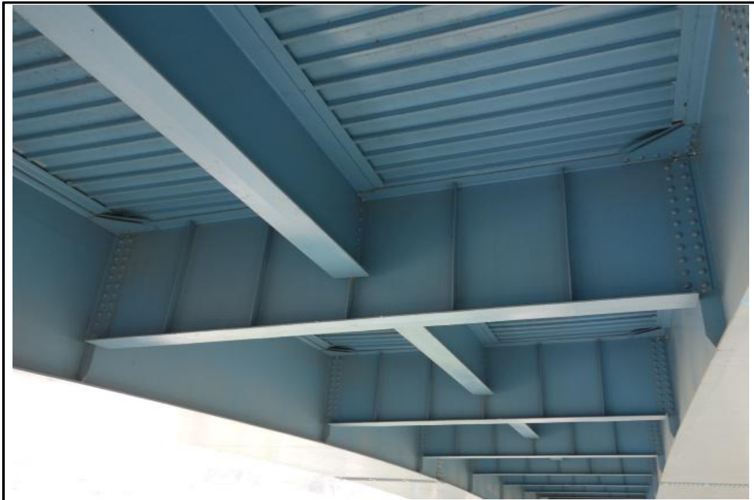
STB 거더 구간 가로보 전경
