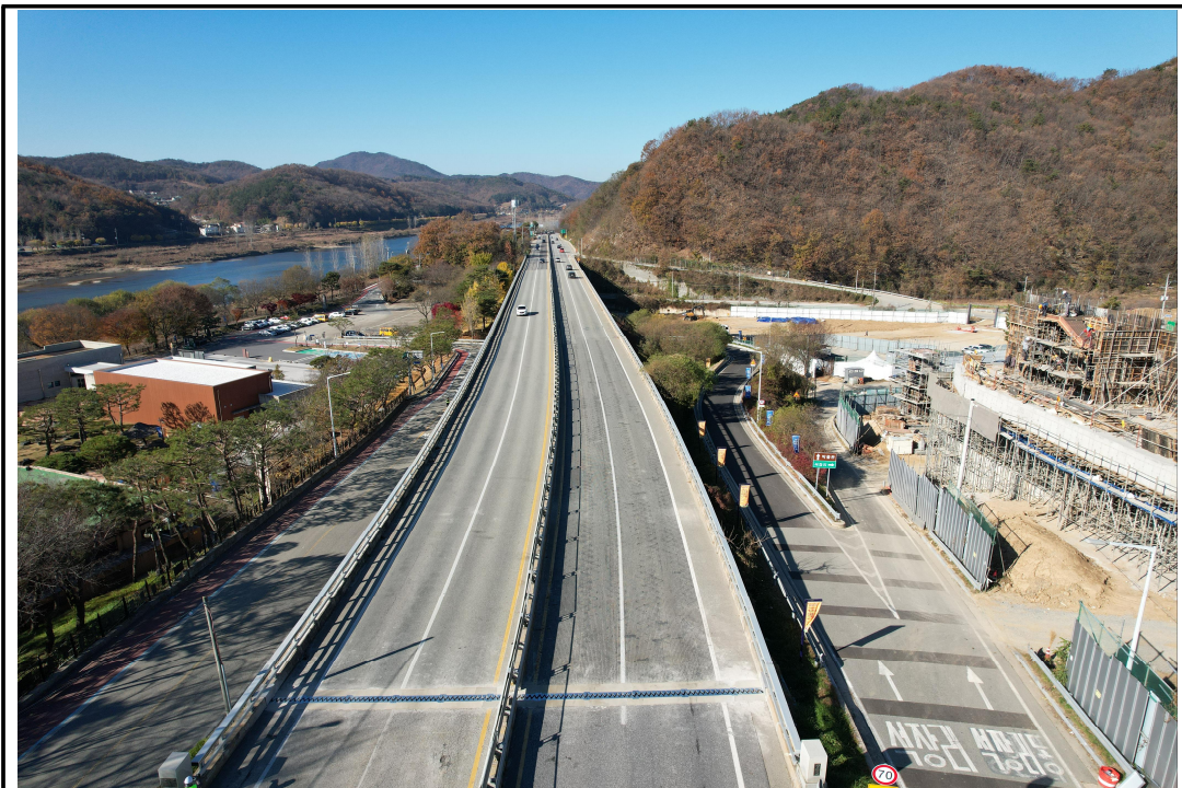
교면포장 및 중앙분리대 전경
