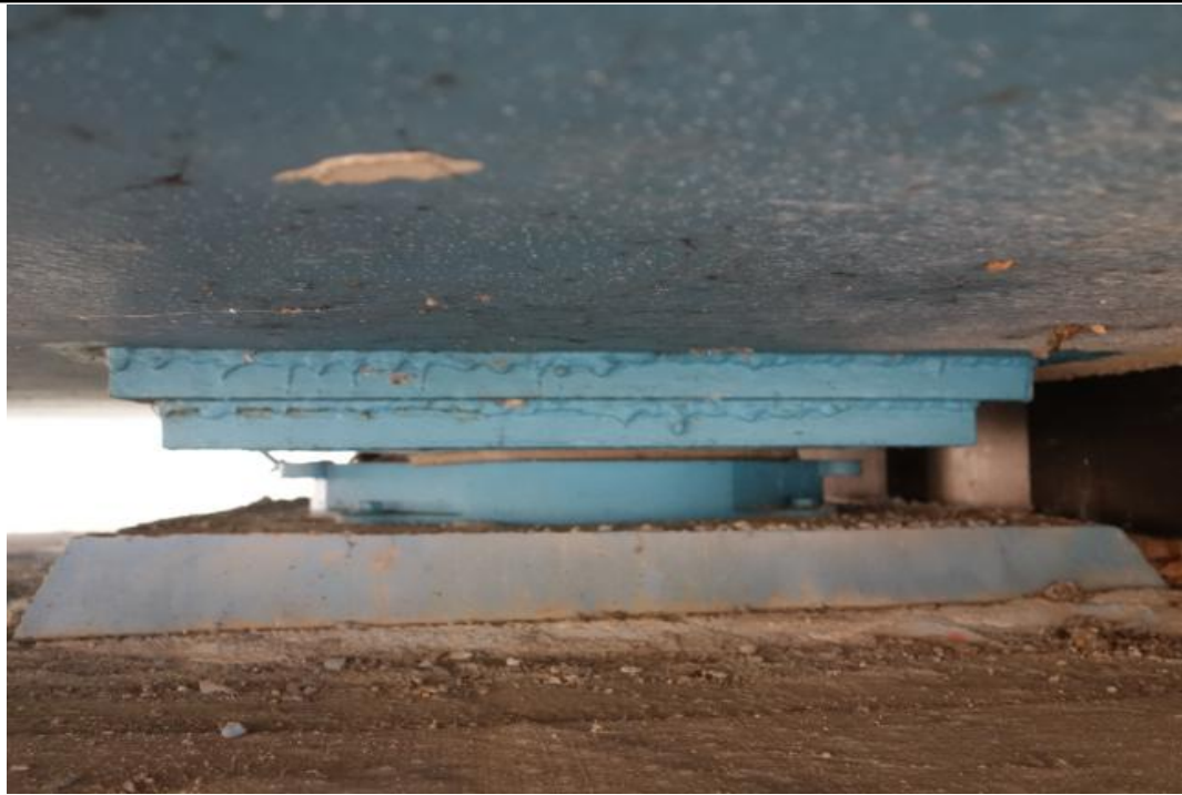
교량받침 전경 (포트받침)
