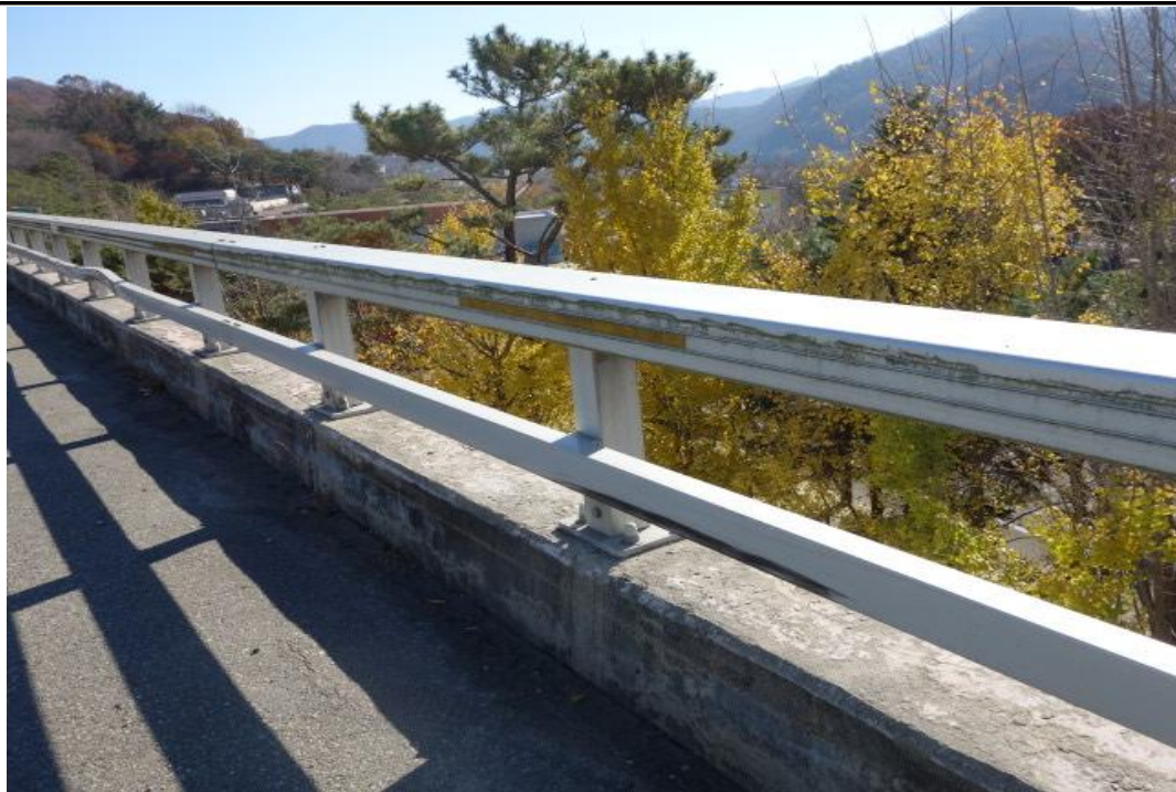
난간 및 연석 전경
